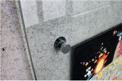
圖三 安藤巧妙設計螺帽（圖片來源： http://pic.ping.tw/barbieedo11/1395805512-414228783_1.jpg ）
